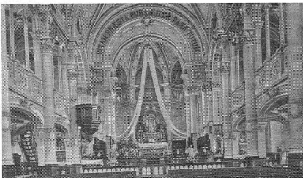
Intérieur de l'église de Saint-Ubalde en 1937
